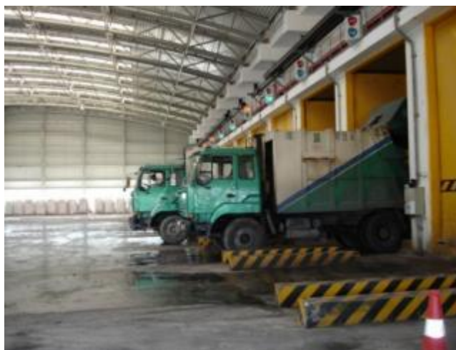
图3.9.3 垃圾卸料大厅
