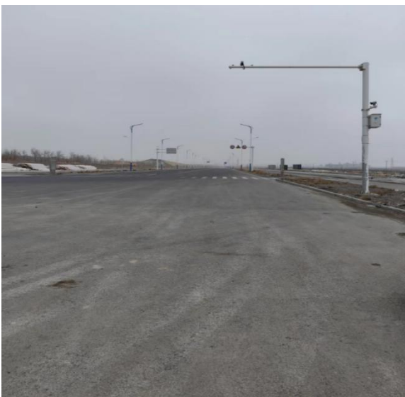
西北侧纬一路
